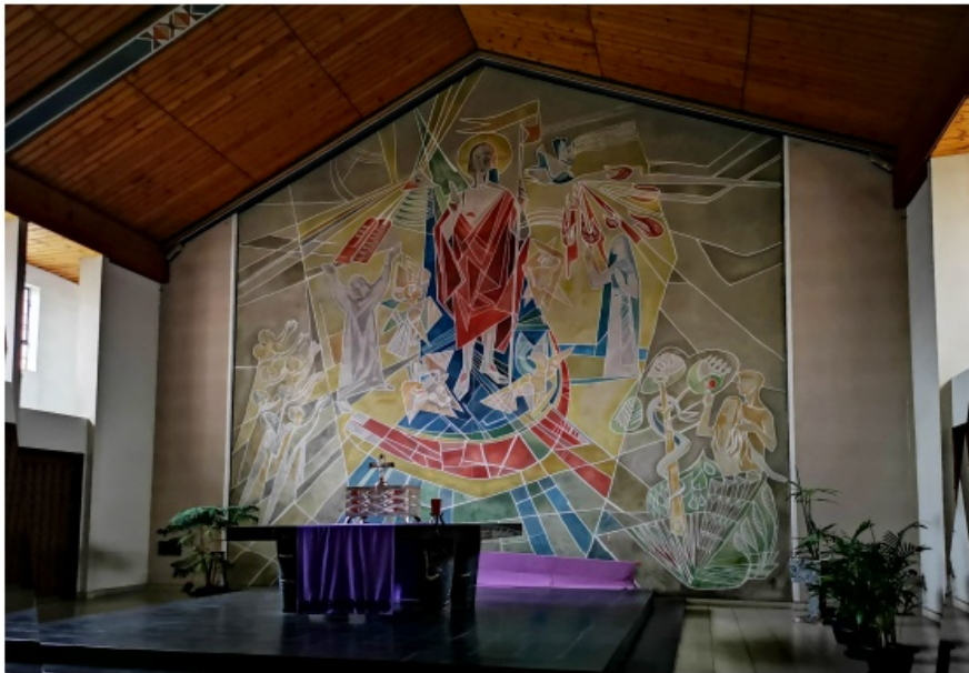
Neuer Pfarrgemeindesaal im ehemaligem Altarraum
